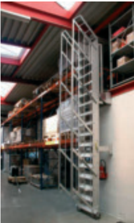
Escalier repliable pour dégager le couloir d'accès au stockage.
