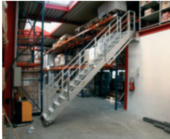
Escalier repliable pour dégager le couloir d'accès au stockage.
