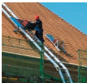
La genouillère permet le passage de l'angle de la toiture.
